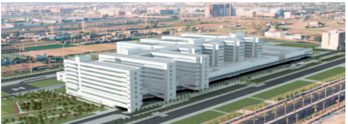
Complejo hospitalario de Boulevard Sur
